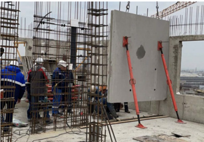
Монтаж сборных железобетонных стен при монолитном строительстве
