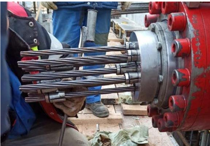
Монтаж большепролетной плиты с преднапряженной арматурой
